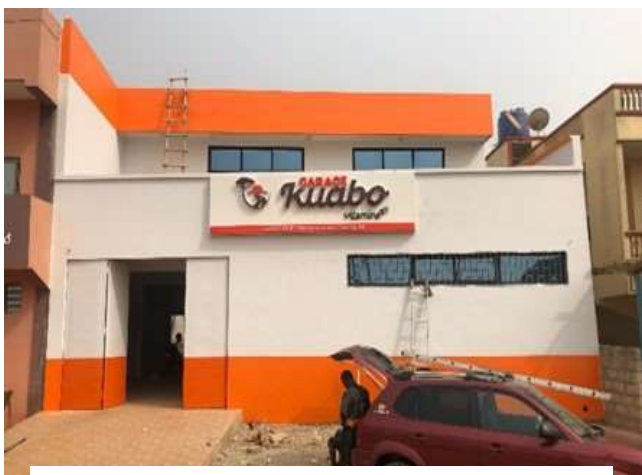
PHOTO 10 : VUE EXTERNE DU GARAGE KWABO INSTALLÉ PAR VITAMINE T
